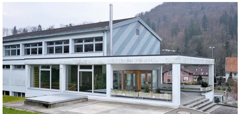
Soll die Turnhalle in Mettau nur saniert werden oder soll eine neue, grössere gebaut werden? Dies ist eines der Themen, über welches an der Zukunftskonferenz der Gemeinde Mettauertal diskutiert werden soll. Foto: Bernadette Zaniolo
