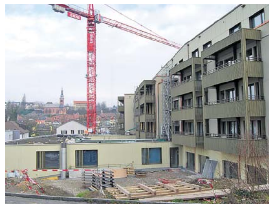
Das Alterszentrum Klostermatte wurde saniert und um die Demenzstation (gelber Anbau) erweitert.
