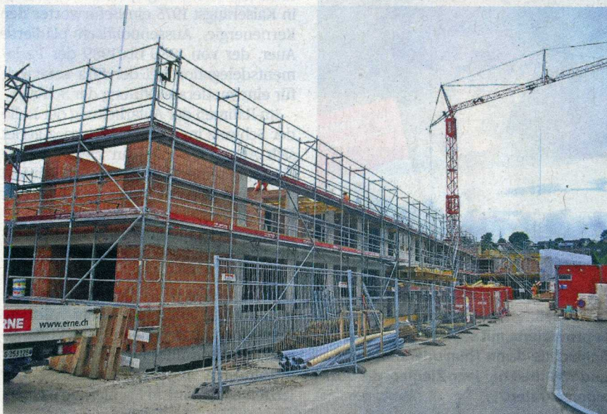
Die beiden Gebäude des VAOF in Laufenburg befinden sich im Rohbau.
