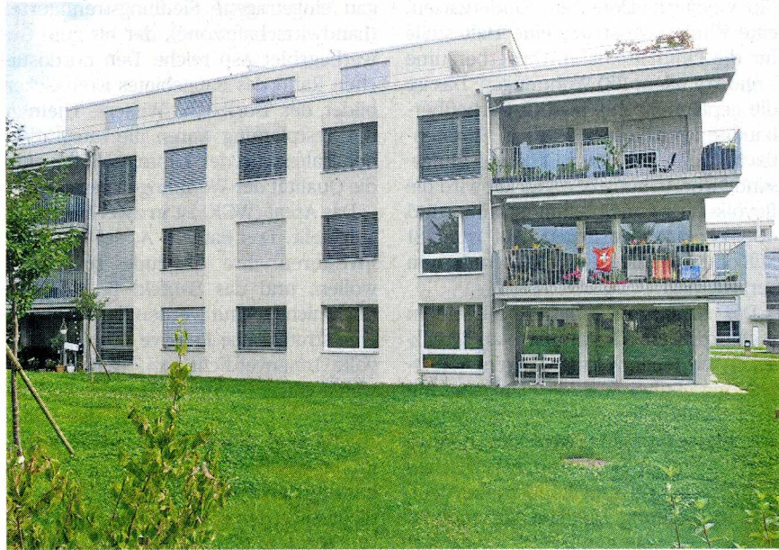
In dieser Erdgeschosswohnung entsteht eine Alterswohngruppe.
