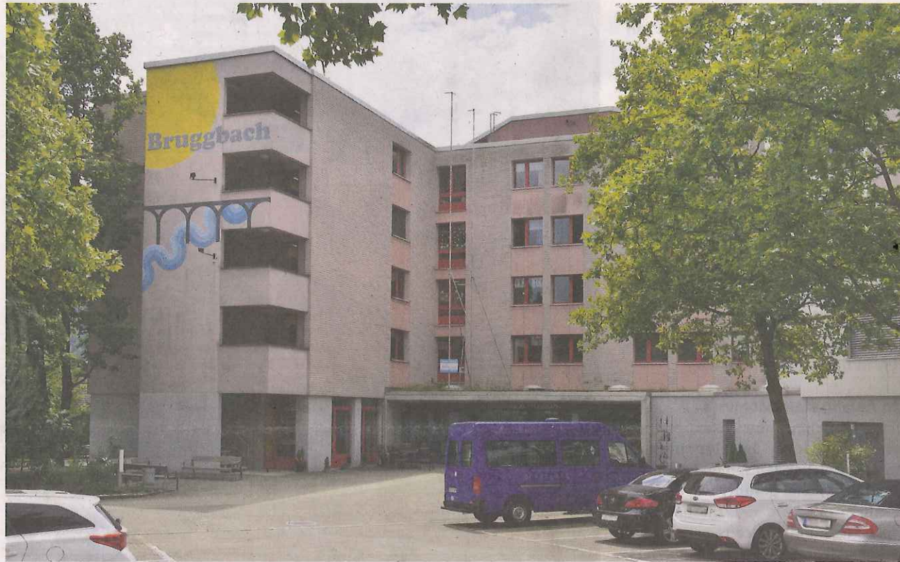
Das Alterszentrum Bruggbach in Frick soll für rund vier Millionen Franken saniert werden.
