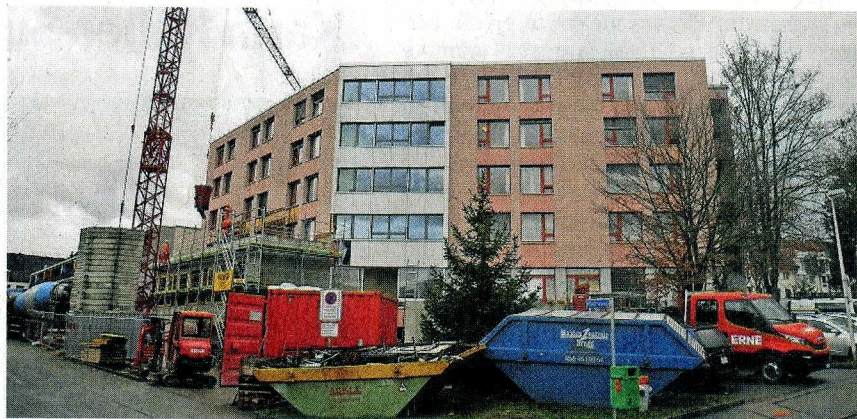
Die Arbeiten am Alterszentrum Bruggbach kommen planmässig voran.
