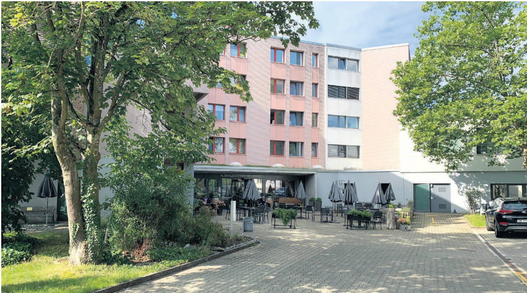
Das Alterszentrum Bruggbach in Frick.
