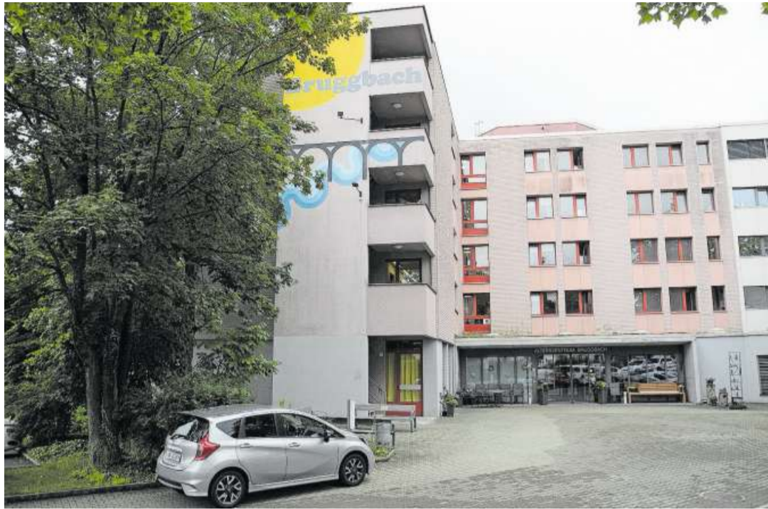
Das Alterszentrum Bruggbach soll umfassend saniert und erweitert werden.
